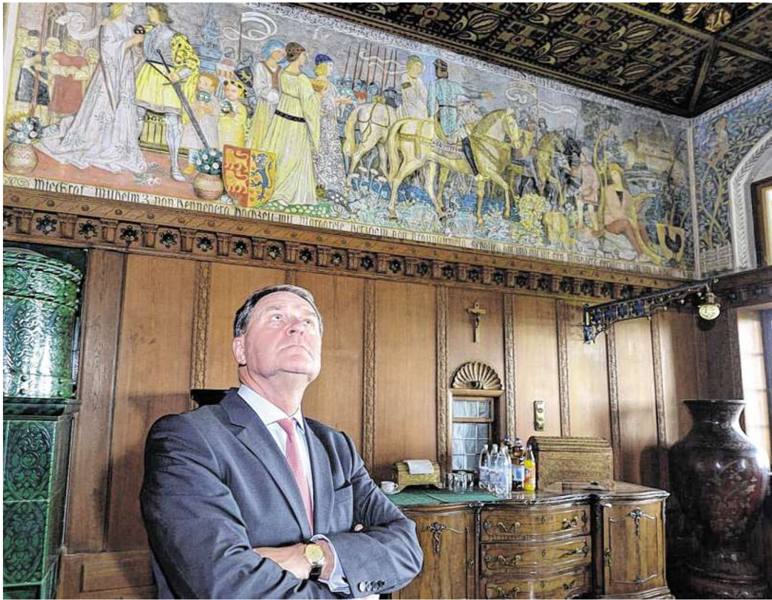
Sorgenvoller Blick: Von oben regnet 's an einigen Stellen rein – von unten destabilisiert ein Luftschutzzoll einen Teil des Schlosses Mainberg. Kunstminister Wolfgang Heubisch will sich gleichwohl für den Erhalt der Burganlage einsetzen, wenn es sein muss, auf Staatskosten. FOTO: ANAND ANDERS
