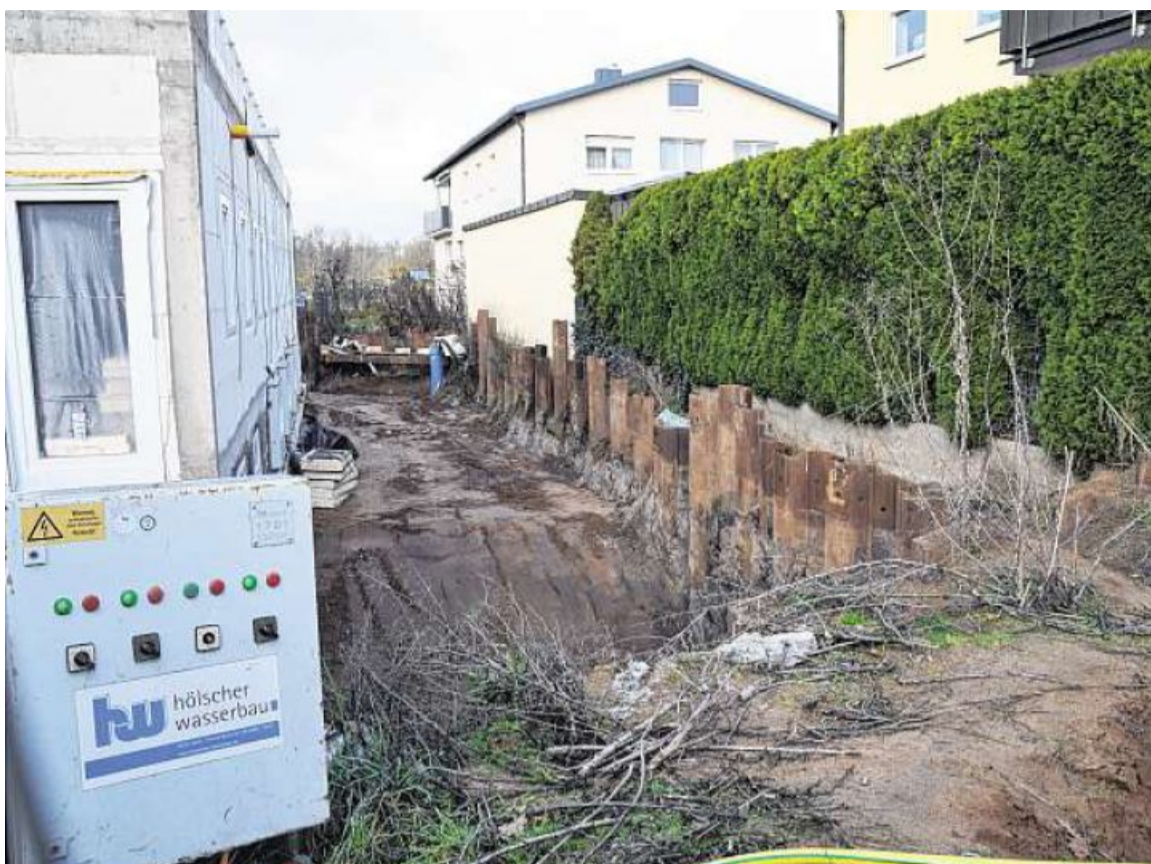
Im November 2019 waren die eisernen Spundwände, die ins Erdreich rund um die Baustelle des Pflegeheims Sennfeld gerammt worden waren, noch sichtbar. Aktuell ist die Baugrube bereits verfüllt. Rechts steht das Nachbaranwesen Rückert, vor dessen Grenze die Spundwände tief in den Boden gerammt sind. FOTO: SILVIA EIDEL
