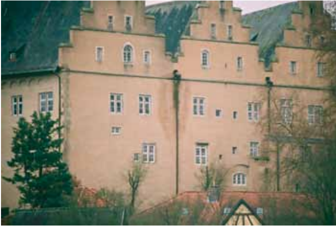
Abb. 3: An der Giebelfront zeigen sich seit 2006 feuchte Flecken, die von Jahr zu Jahr größer werden.
