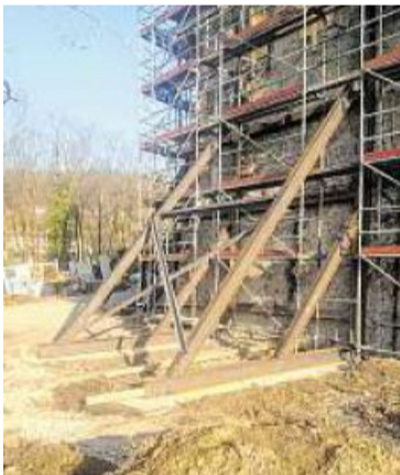
Die Vorburg wurde abgestützt.
