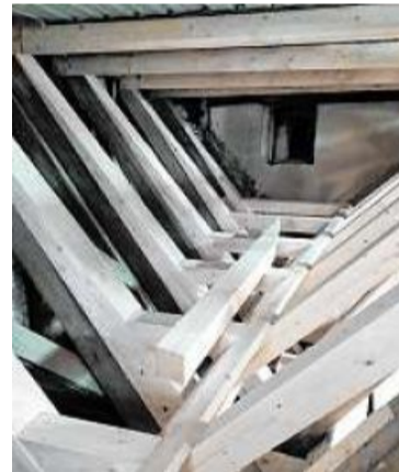
Eingebaute Notsicherung im „Dachgraben“ zwischen Haus 2 und 3.
