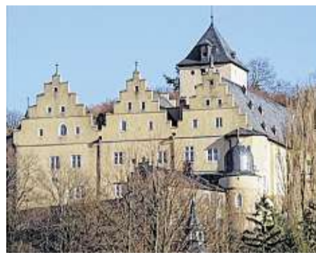
Das Schloss von außen: Mainberg, einst prunkvoller Industriellensitz, ist heute ein Sorgenkind der Denkmalpflege.
